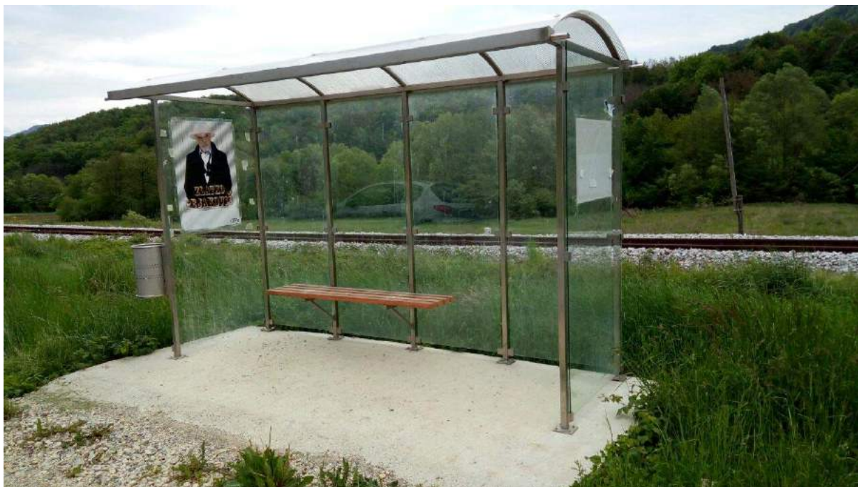
2.2.-4. Autobusno stajalište na lokaciji
